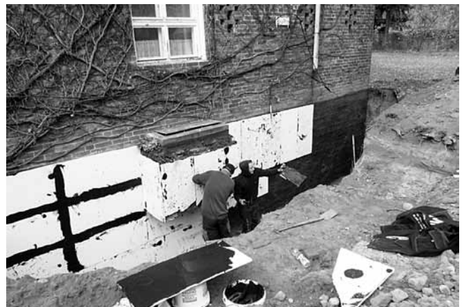
Gemeindehaus Hittorfstraße 21 – Isolierung der Kellerwand (Bild: K. Tietze)
