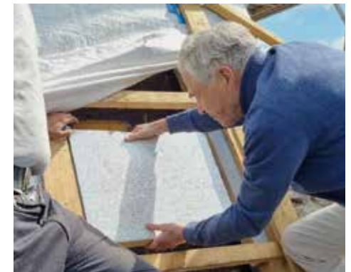
Bemusterung der Zwischensparrendämmung
